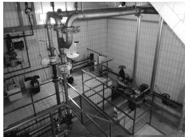
Das Innere des neuen Hochbehälters
