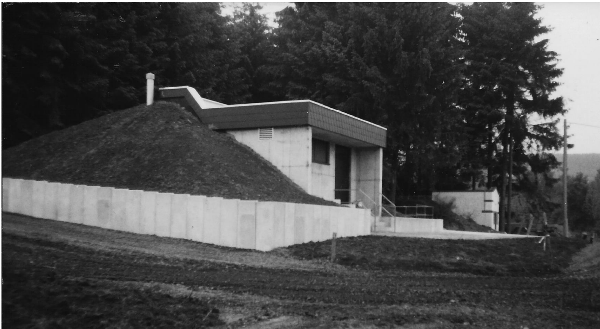
Die im Bau befindliche Pumpenanlage und im Hintergrund das 1936 erbaute Wasserhäuschen
