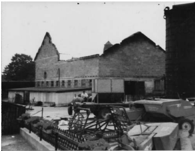
6 Wochen später der 2. Großbrand. Am 15. August 1974 fielen Scheune und Stall des landwirtschaftlichen Anwesens von Hubert Becker im Mühlenweg zum Opfer.
