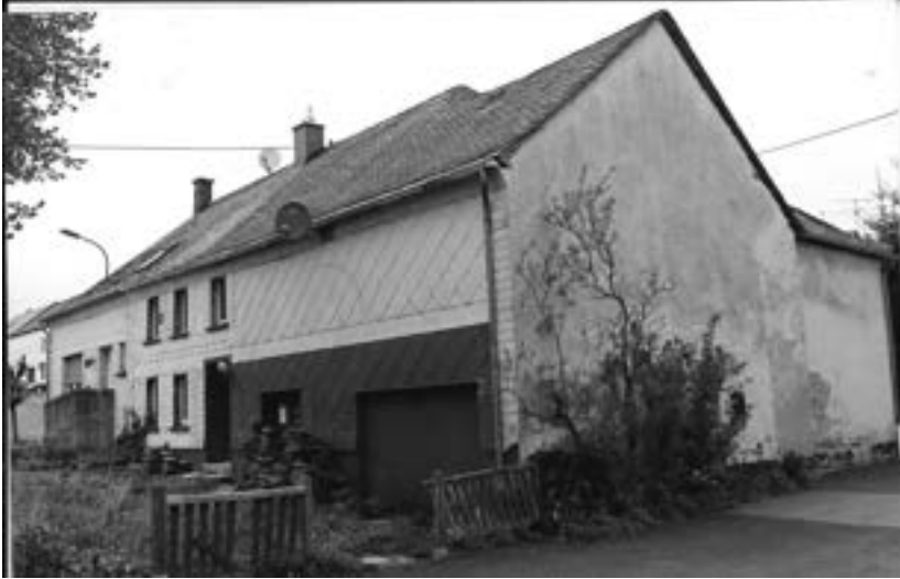
„Schetzenhaus“ erbaut 1870 lfd. Nr. 184
