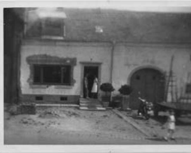
...und nach dem Umbau 1963
